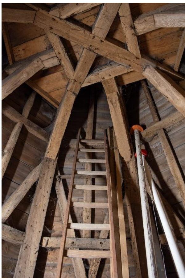
De binnenkant van de torenspits.
